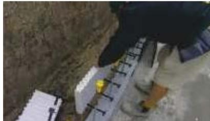
Die äußere Dämmschale wird mit den Abstandhaltern auf die Bodenplatte gestellt.
