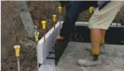
Im Eckbereich werden die innere und die äußere Schalung jeweils gestoßen, damit es einen durchgehenden Betonkern ergibt.
