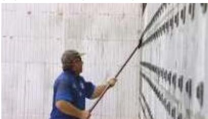
Bereits am folgenden Tag können mit einem Schaber die Halteteller an den Sollbruchstellen entfernt werden.
