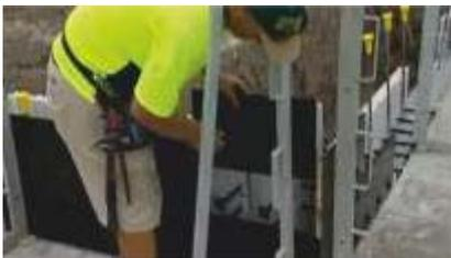
...und entsprechend eingeschoben werden. So wird Wandlage für Wandlage im oder gegen den Uhrzeigersinn aufgesteckt.
