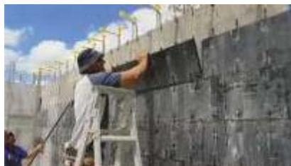
Die Boards lassen sich leicht abnehmen, in den Gestellen stapeln und sind somit für das Schalen den nächsten Wand einsetzbar.
