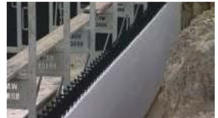
Die äußere Dämmschicht rastet durch den Steckverschluss - wärmebrückenfrei - ineinander.
