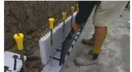
Das innere ReFORM Board wird in die Schlitz über die Abstandhalter gesteckt.
