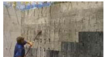
Erneut werden mit dem Schaber die Kunststoffstege entfernt - zurück bleibt eine glatte, massive Betonoberfläche.
