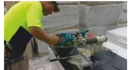
...das ReFORM Board mit einer handelsüblichen Kappsäge passgenau zugeschnitten...
