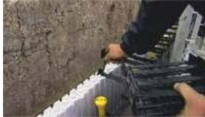
Die Abstandhalter werden fortlaufend in die Dämmschicht und in die ReFORM Boards geschoben.
