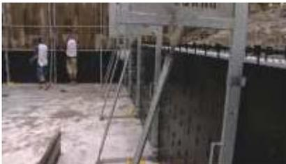
Die Richtstützen werden, für eine lot- und fluchtgerichte Wand, auf die Bodenplatte gedübelt und an den Boards verschraubt.
