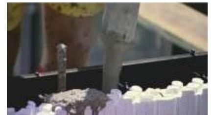
Durch Stochern wird der Beton ausreichend verdichtet. Vorsichtig kann auch mit einem kleinen Flaschenrüttler gearbeitet werden.
