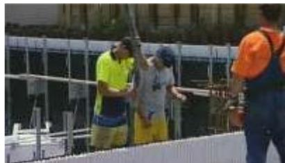
Mit der Betonpumpe wird der Beton C 20/25 in der Konsistenz F 3 geschosshoch eingebracht.
