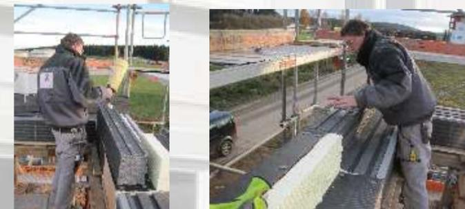
Mit der Schaumpistole wird in die hinterschnittenen Nuten der Montageschaum aufgetragen und die Elemente auf dem Mauerwerk oder dem Rolladenkasten verklebt.
